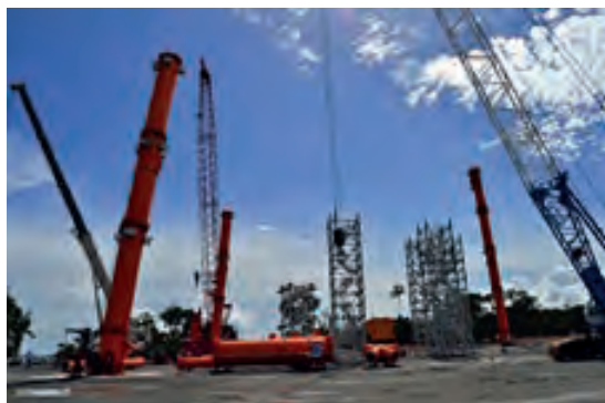
Construcción de una línea de transmisión en la Amazonía brasileña. Fuente: cemento.itambe.com.br .
