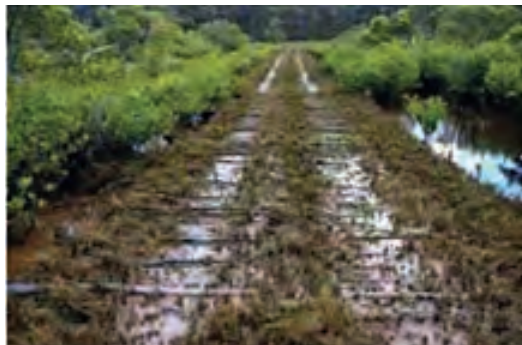
Trocha afianzada con troncos en terreno húmedo (corduroy). Fuente: EIA de la línea de transmisión Moyobamba-Iquitos.
